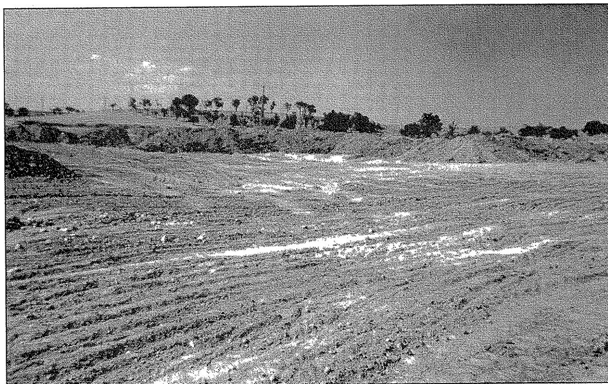
**Figura 2.** Desde finales de 1994 se transformaba totalmente la vaguada con la obra de acondicionamiento y preparación del terreno. La maquinaria desmontó directamente los dos primeros metros del terreno (fotografía del 8.VII.1995, vista desde el sur/sureste)
