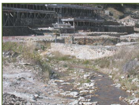
Detalle del Río Muera con las salinas en la ladera
