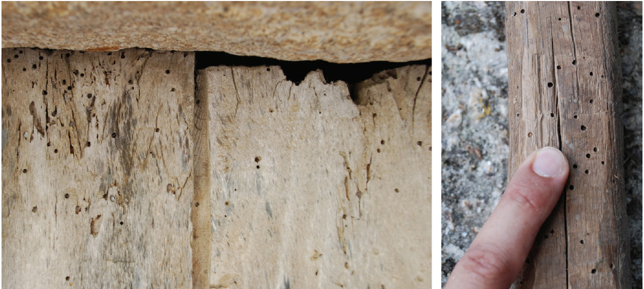
Fig. 1. Típicos agujeros de salida (redondos y de 1,5-2 mm de ancho) producidos por los adultos de Anobium punctatum (De Geer, 1774) (Coleoptera: Anobiidae), especie cosmopolita conocida como "carcoma común de los muebles".
