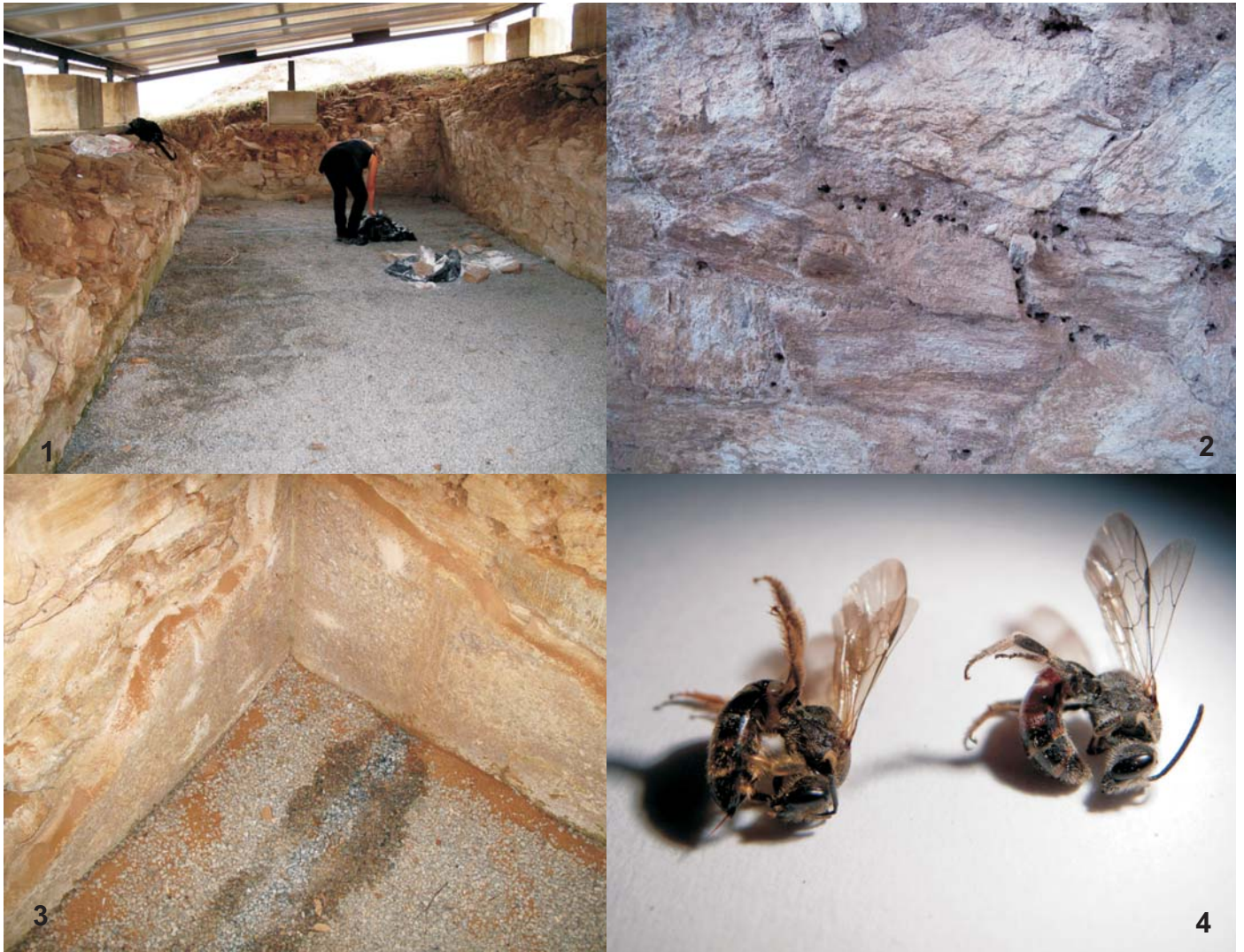
Fig. 1. Interior de la cisterna inferior. Fig. 2. Orificios practicados en la argamasa. Fig. 3. Mampostería hidráulica conservada y arenilla depositada en el suelo, resultante de la perforación. Fig. 4. Hembra (izquierda) y macho (derecha) de Lasiglossum nigripes .
