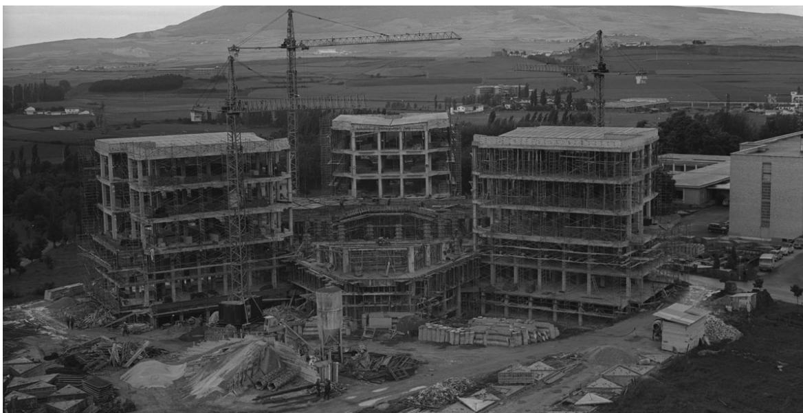
Construcción de la Facultad de Ciencias
